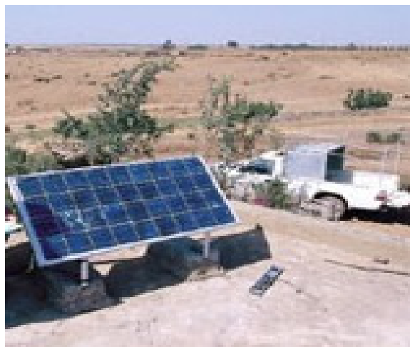
PROJET D'ÉLECTRIFICATION RURALE AUX PHOTOVOLTAÏQUES
