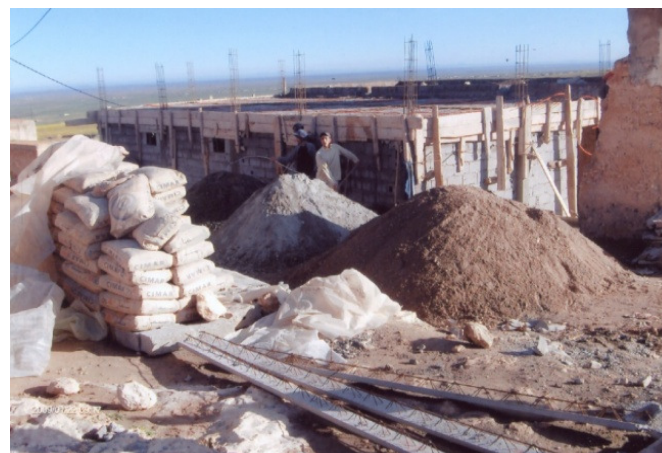
CONSTRUCTION D'UNE MOSQUEE
