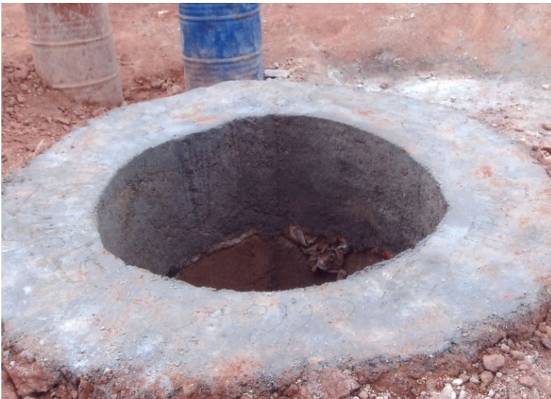
Creusement de puits
