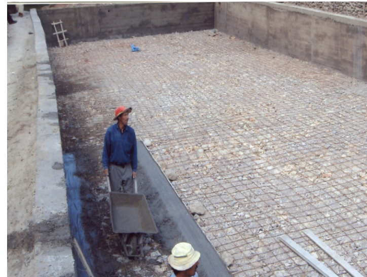
Construction de bassin d'accumulation
