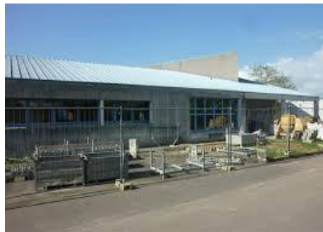
Travaux à l'Espace Valentin
