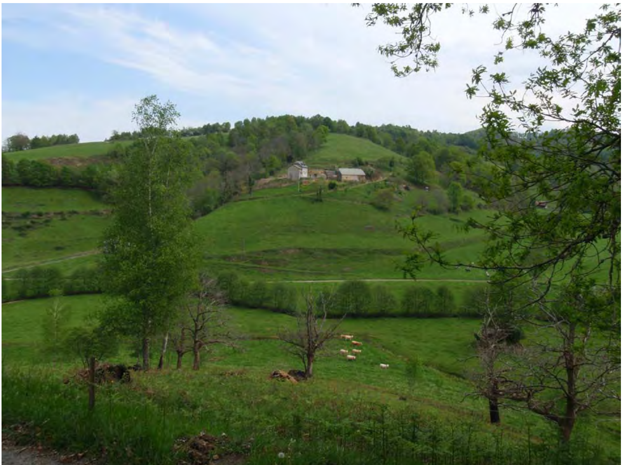
Illustration 14: L'axe du barrage d'Arrayou vu de la rive gauche
