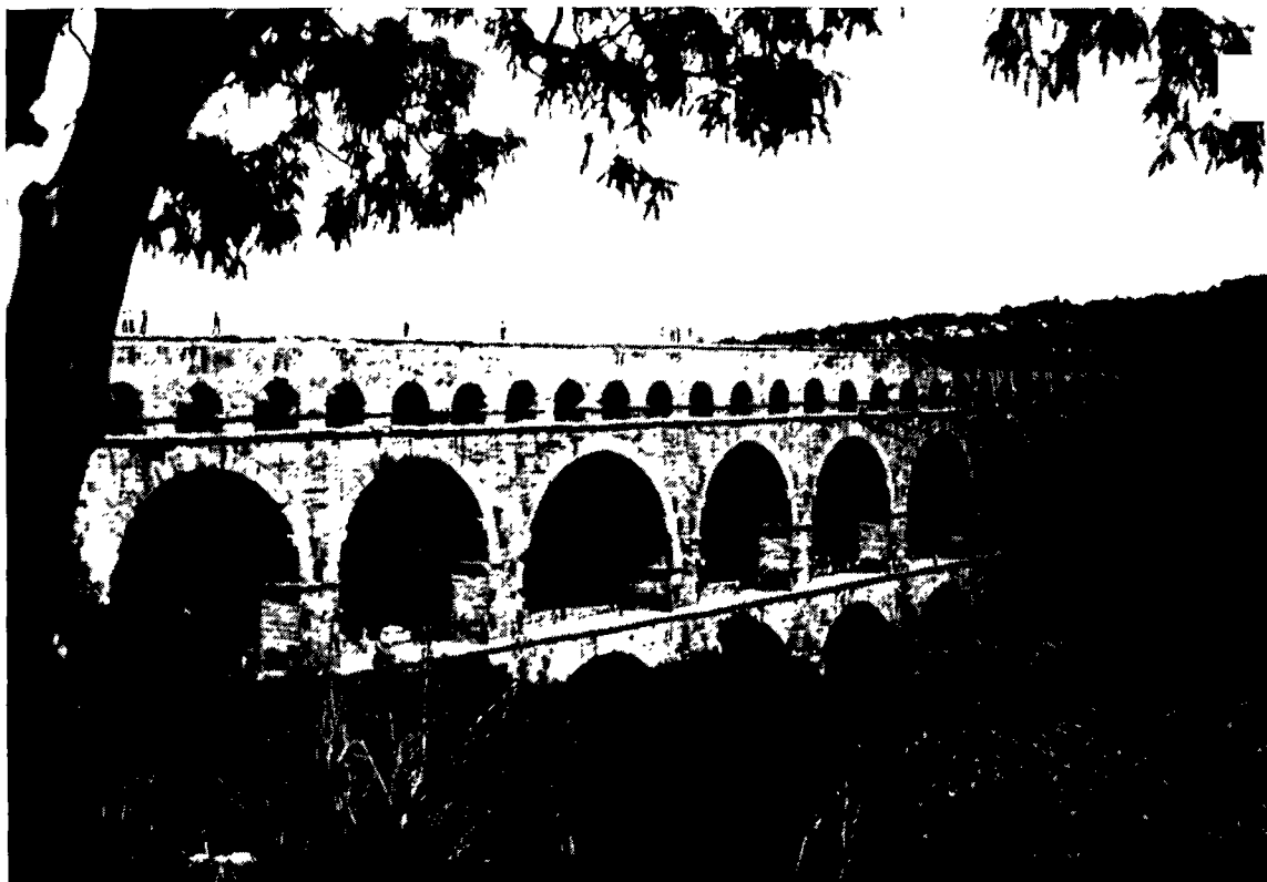
FIG. 6. Adduction d'eau à Nîmes (1 er siècle de notre ère), sur le Gard (pont du Gard). [Photo : Gunther Garbrecht.]
