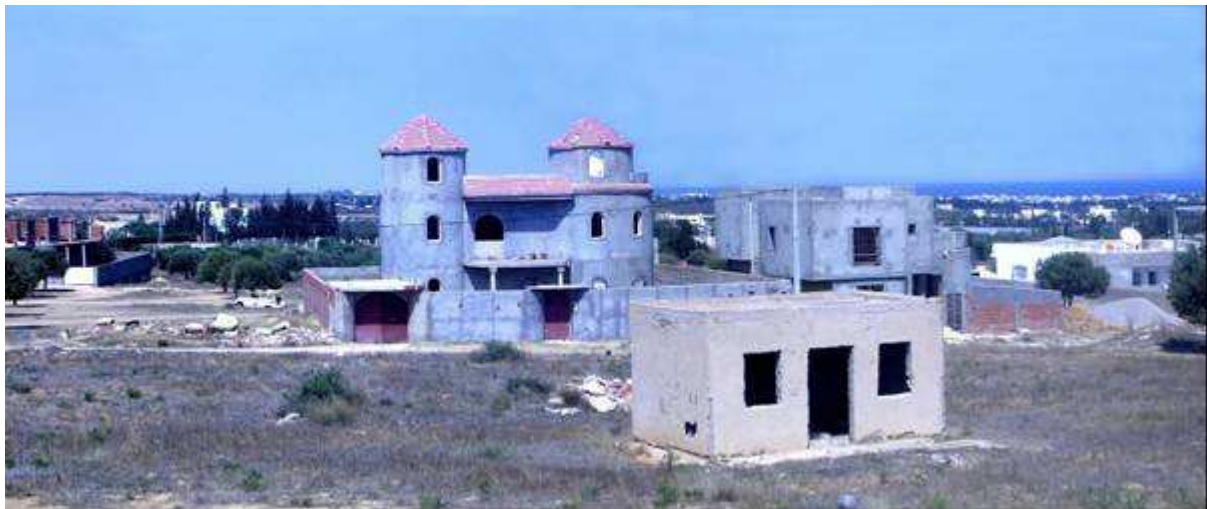
Figure 70 : Début d'urbanisation d'un meskat dans l'espace périurbain de Chott Mariem (Sousse Nord) : émergence des constructions sur l' impluvium au premier plan et dans les mankâas plantés d'oliviers au second plan
