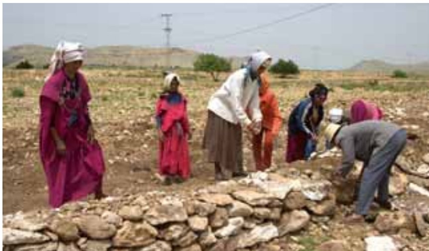
Des participants au programme construisent un cordon en pierres pour intercepter les eaux de ruissellement et les faire pénétrer dans le sol afin qu'elles ne se perdent pas.
