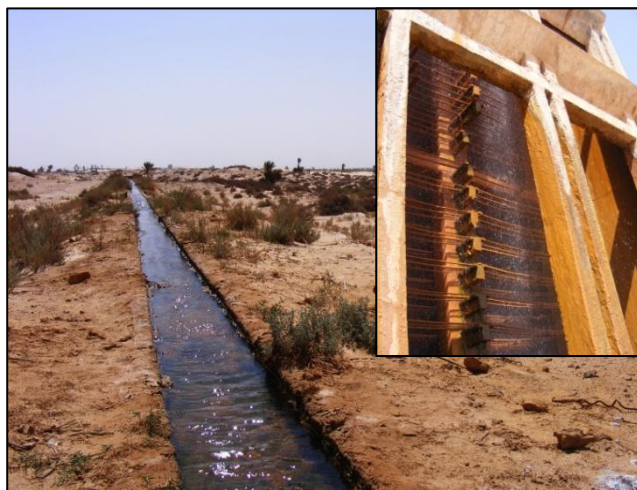
Fig. 5. Instalații de răcire și distribuire a apei pentru irigații
