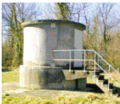
Réservoir de stockage d'eau potable
