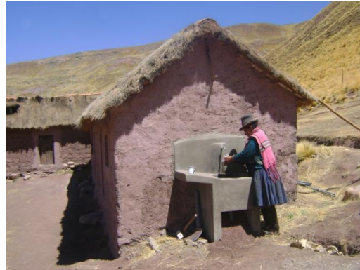
Figure 1: A domestic water supply in Peru. Photo: Soluciones Prácticas.
