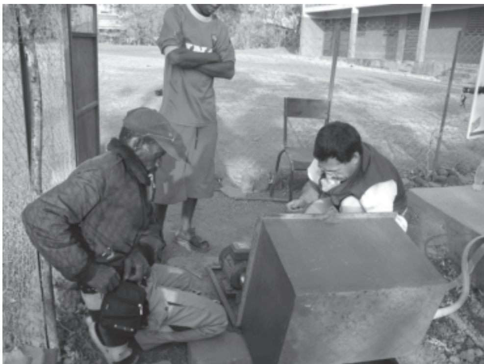
A Dano Jean-Paul et Antoine refendent la courroie de la pompe Volanta
