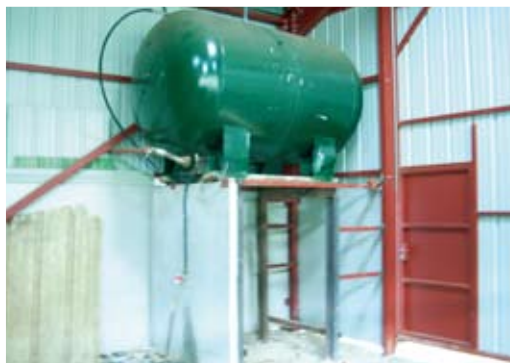
La réserve d'eau remplie par la pompe à béliet
