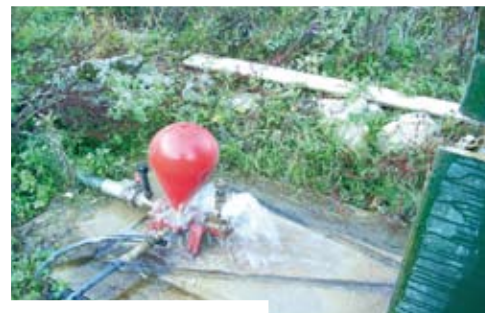
La pompe à béliet avec cache de protection
