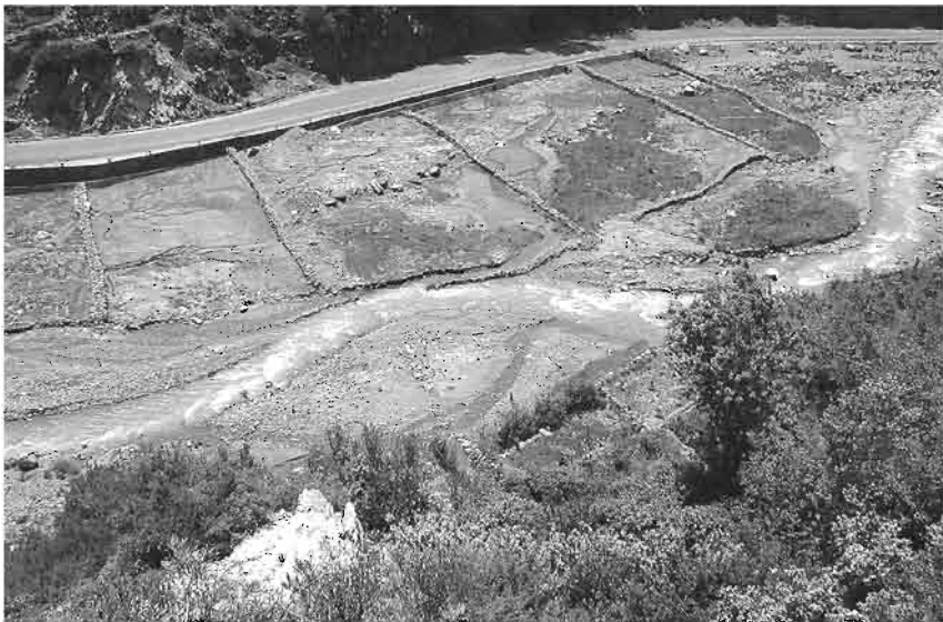
Restauration après une crue dévastatrice du lit majeur dès l'oued Rêrhaya sur une succession de murettes perméables
