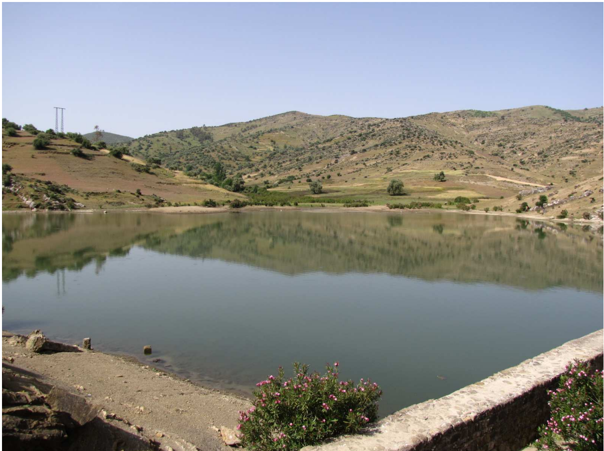
Lac collinaire dans la région nord Marocain installé pour contrer le problème d'envasement d'un barrage en aval.
