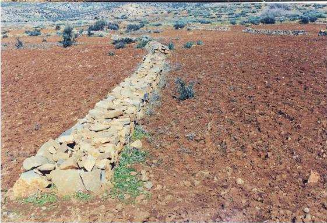
Une vue de près sur une murette.
