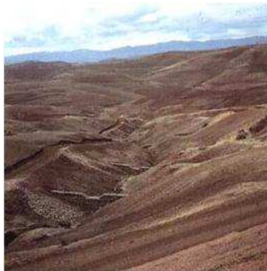
Série de seuils en maçonnerie.
