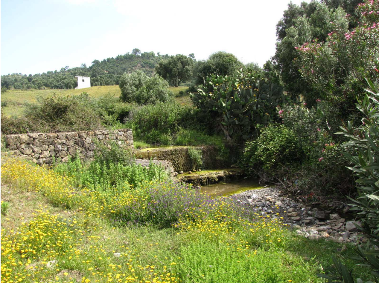
Un zoom sur un seuil construit en maçonnerie sur un ravin dans la région rifaine au Maroc.
