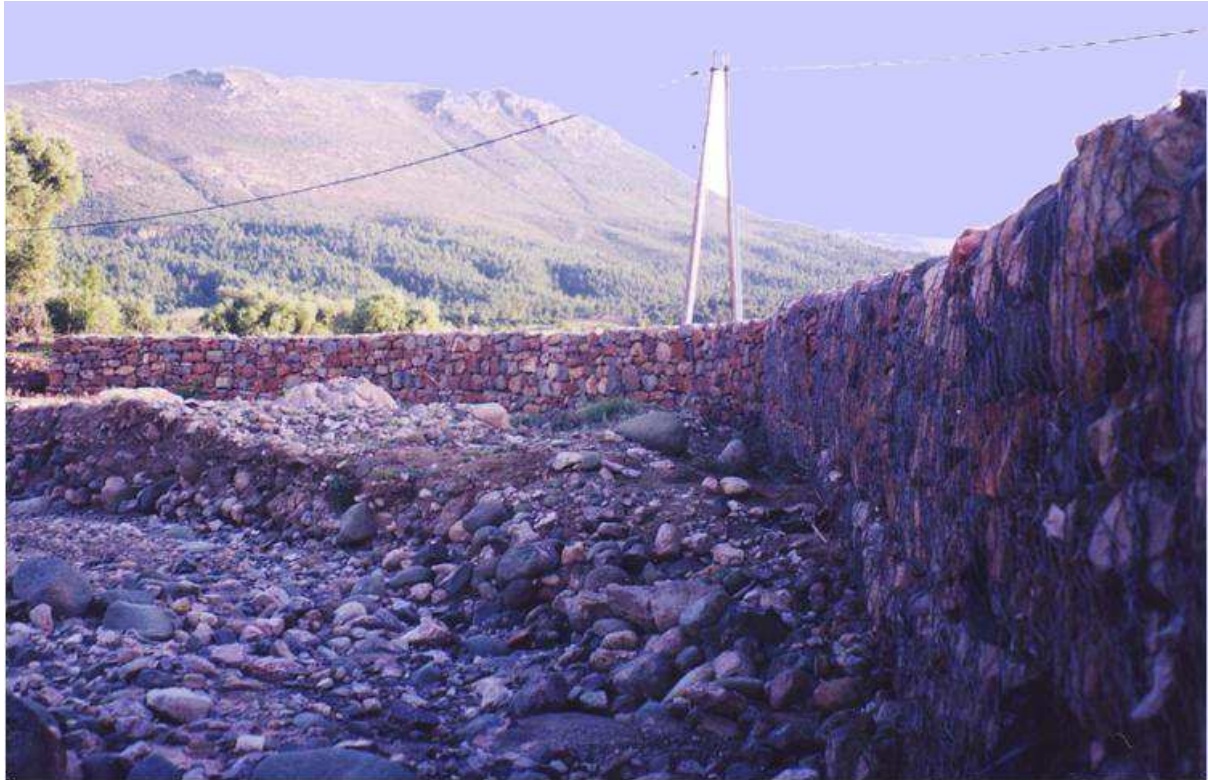
Mur en gabions, construit par l'Etat (Tizgui au Maroc).
