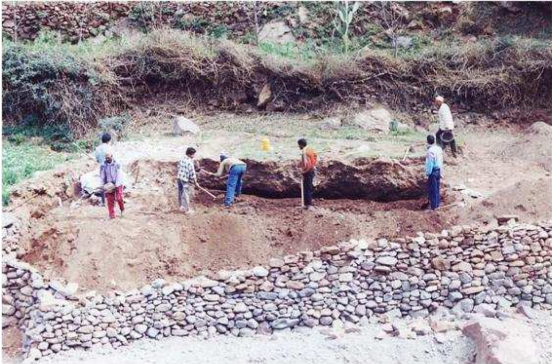
Construction d'une terrasse.
