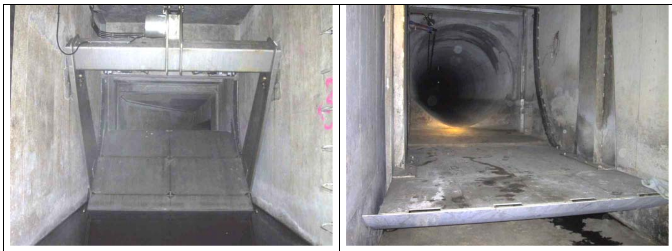
Figure 17 : Exemple de vanne secteur
