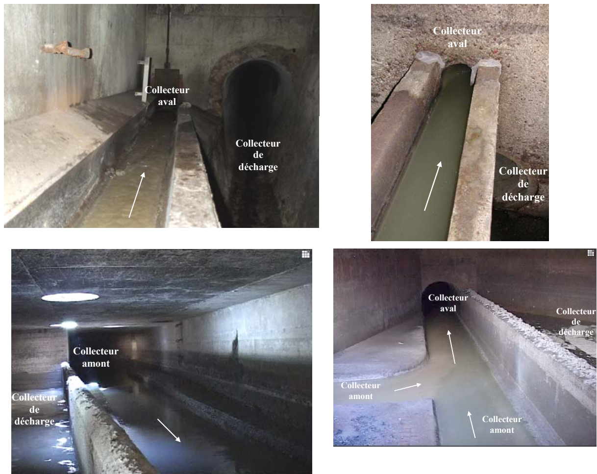
Figure 2 : Exemples de déversoir
