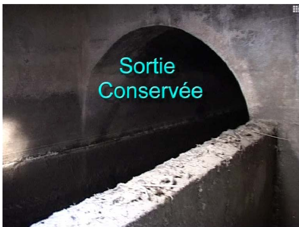
Figure 33 : Exemple de déversoir à seuil bas
