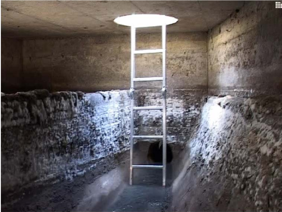
Figure 35 : Exemple de déversoir à seuil haut
