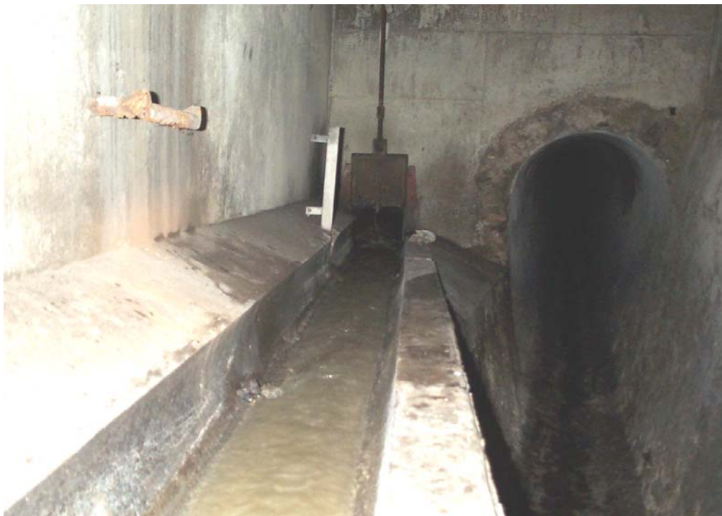
Figure 21 : Exemple de déversoir latéral à seuil simple
