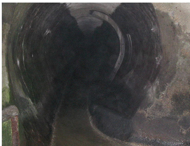
Figure 85 : Collecteur d'apport vu vers l'amont, au niveau du batardeau
