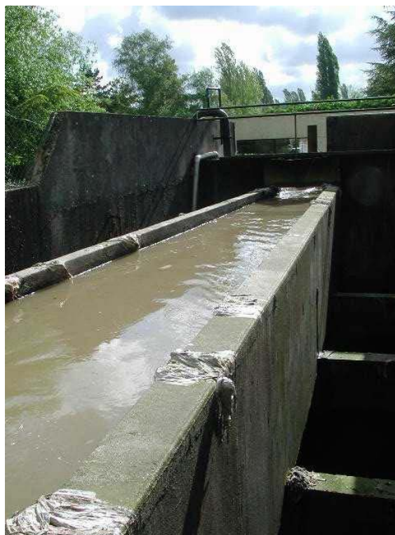
Figure 88 : Déversoir d'orage vu vers l'aval
