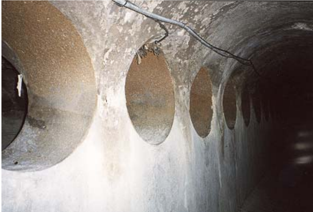
Figure 13 : Exemple de déversoir à trou
