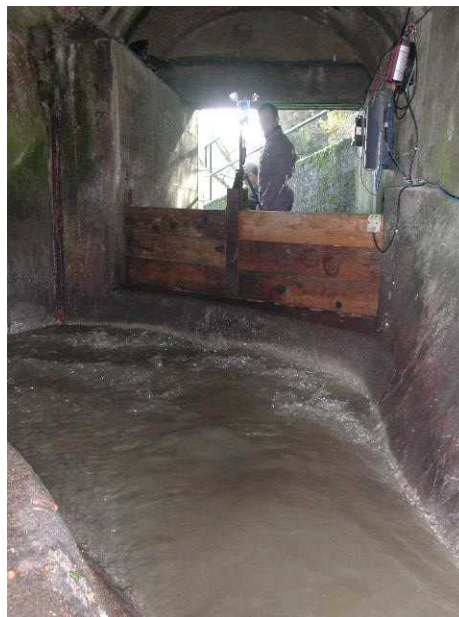
Figure 96 : Surélévation du seuil du batardeau à l'aide de planches
