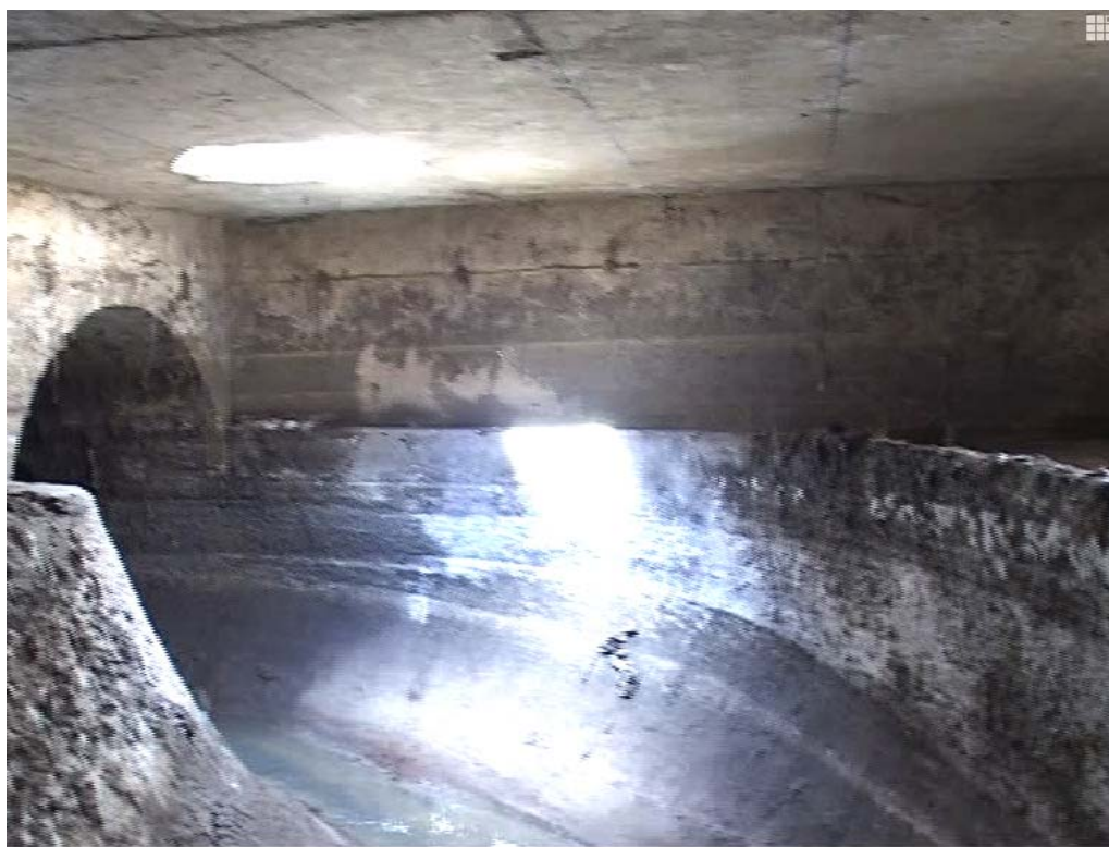
Figure 31 : Exemple de déversoir à seuil curviligne
