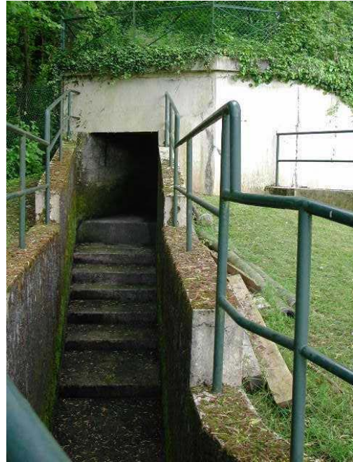
Figure 95 : Accès au batardeau et au collecteur d'apport.
