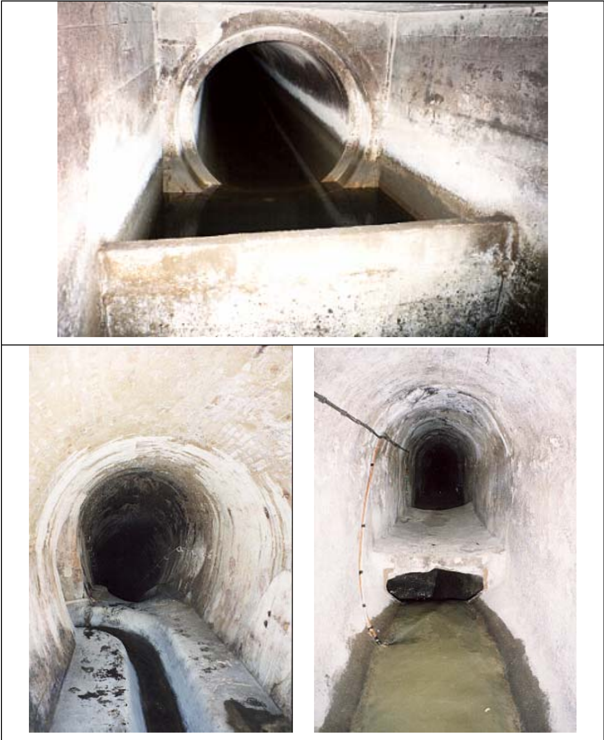
Figure 29 : Exemples de déversoir frontal
