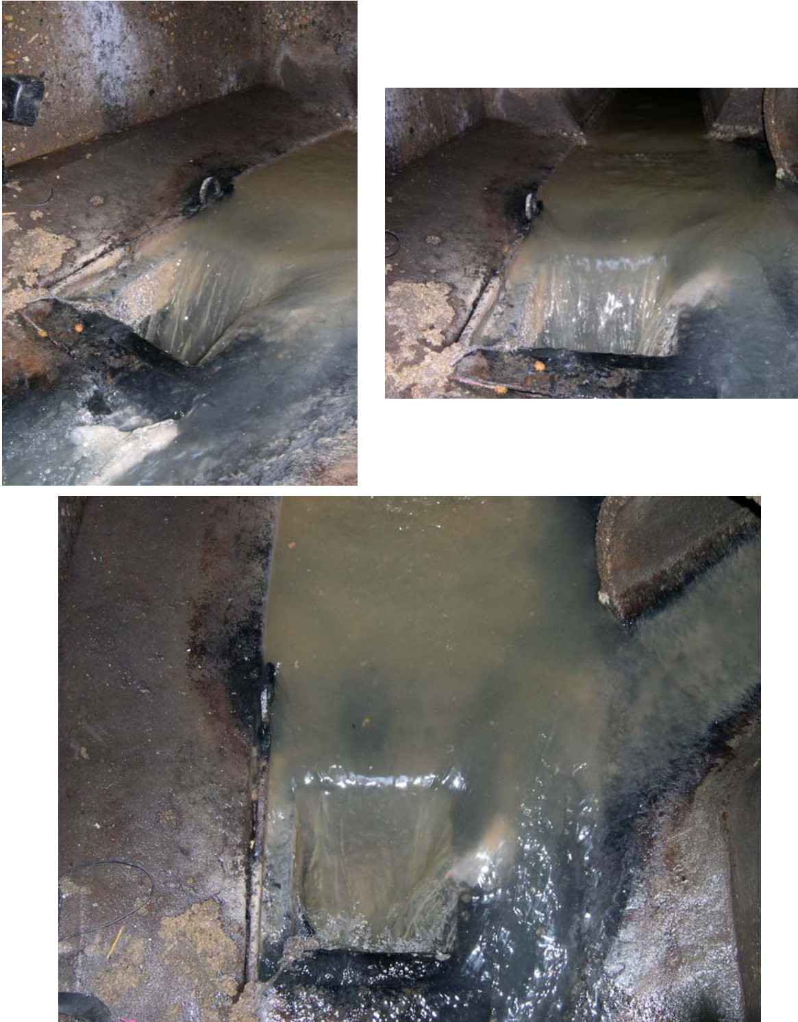
Figure 15 : Exemple de déversoir leaping weir
