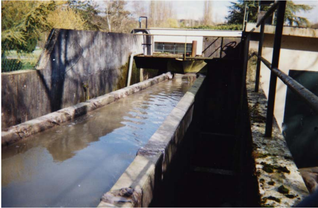
Figure 23 : Exemple de déversoir à seuil double
