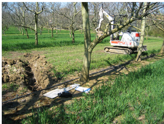
Exemple de profil racinaire effectué avant le démarrage de la végétation
