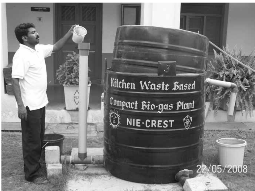
Le système de biogaz installé par le Centre For Renewable Energy and Sustainable Technologies (Centre des Technologies Appropriées et des Energies Nouvelles et Renouvelables (CREST)), une branche de l'Institut National des Sciences Appliquées (NIE). Il fournit aujourd'hui du gaz à usage culinaire à un restaurant d'entreprise.
