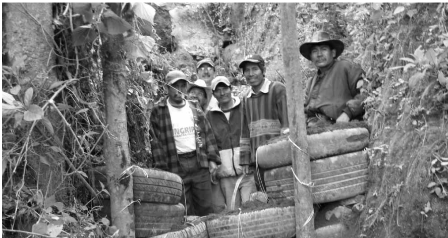
Les effondrements et les ravins sont comblés avec des troncs d'arbres et de vieux pneus. Les résidus de plantes y restent et progressivement reconstituent le sol.
