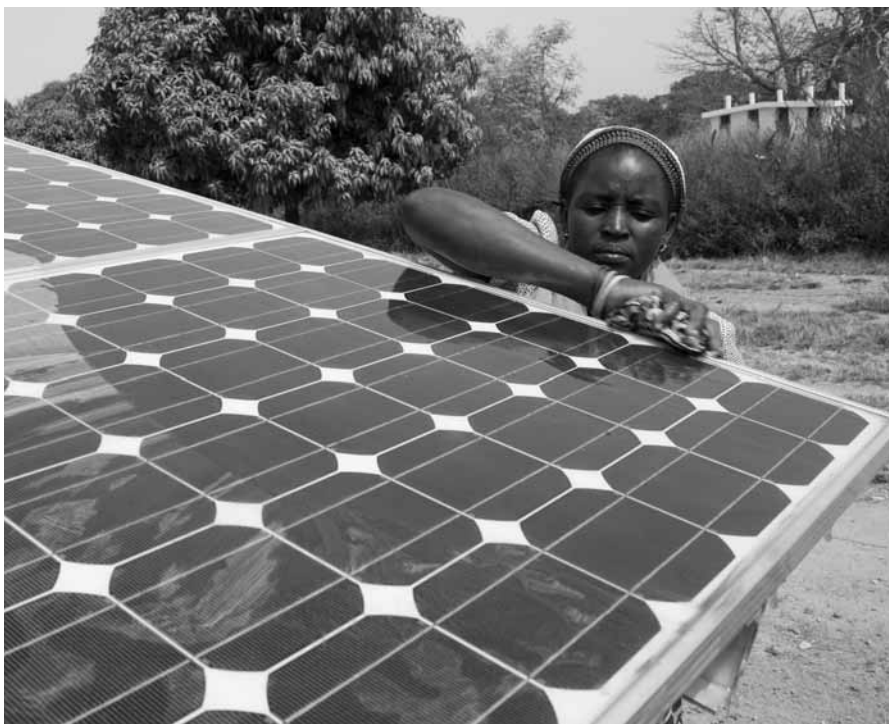
Une femme nettoie un panneau solaire faisant fonctionner le système d'irrigation goutte à goutte dans un village du Bénin.
