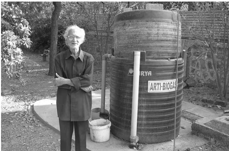
Ajit Gokhale et son système de biogaz qu'il alimente avec des restes de nourriture.
