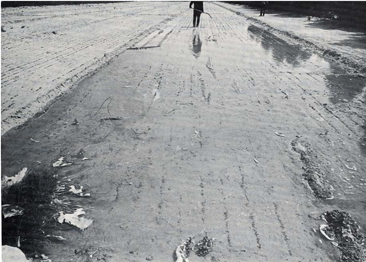
Figure 52 Mise en eau des planches
