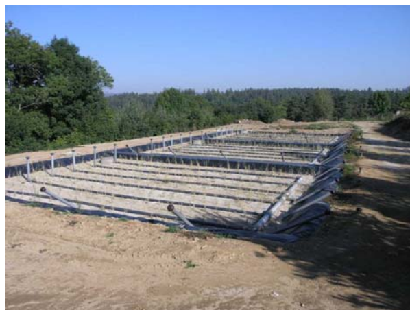
Alimentation par drains, posés au sol
