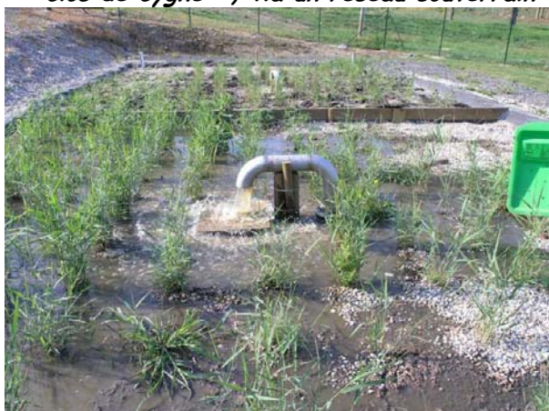
Alimentation par débordement « clos de cygne », via un réseau souterrain
