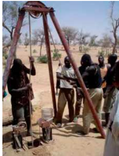
Fonçage photo fondation practica
