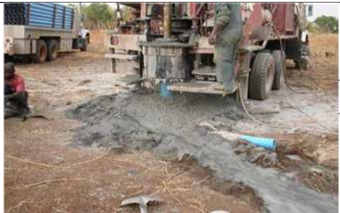
Forage d'un puits au TOGO - Photo Caritas Kara
