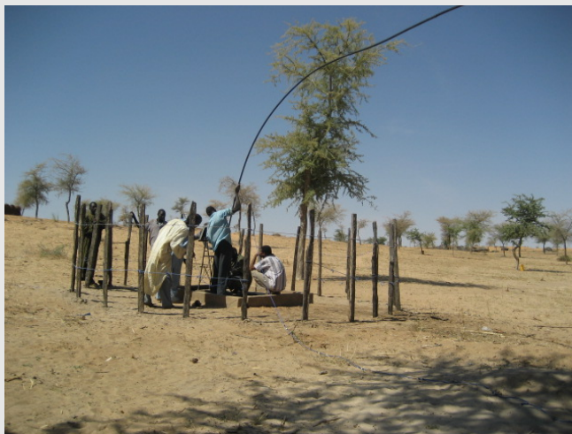
Photo : Réparation de la corde par les usagés
