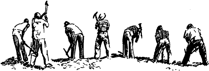
Figure 5 : Creusement d'une mare en chantier HIMO (haute intensité de main-d'œuvre).
