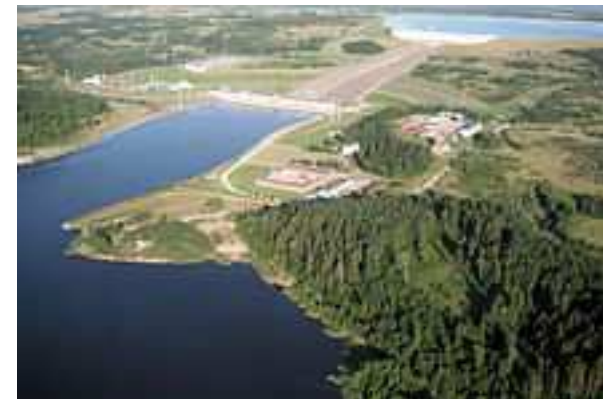
Centrale de pompage-turbinage de Kruonis en Lituanie (900 MW - extension ultérieure à 1600 MW en projet). Source : http://fr.wikipedia.org/wiki/Pompage-turbinage
