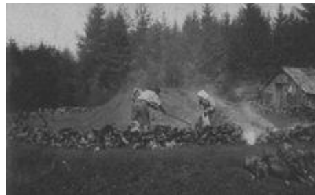
Le démontage de la meule
