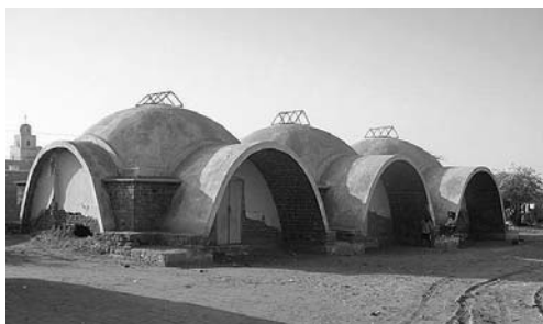
Figure A3.2 Rosso (Mauritanie) 1979 : École construite en technologie de terre et de voutes par l'ONG ADAUA
