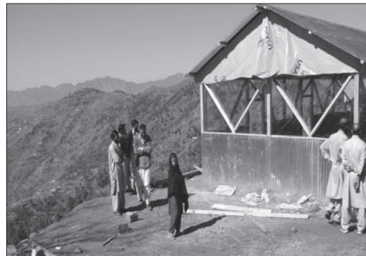
Figure 13: Écoles temporaires en bois et tôle ondulée, Pakistan
