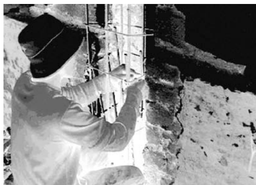
Figure 15: Modernisation antisismique d'une école en Indonésie
