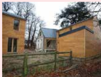
Sainte-Geneviève-des-Bois pendant travaux (Décembre 2011)
