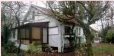
Sainte-Geneviève-des-Bois avant travaux
