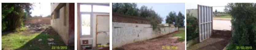
L'état des bâtiments avant les travaux.
