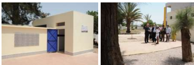
L'état des bâtiments après les travaux.
