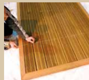
Alignement au cordeau des trous de fixation.
