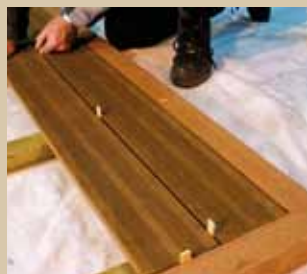
Utilisation de cale pour conserver l'écartement régulier des lames.
