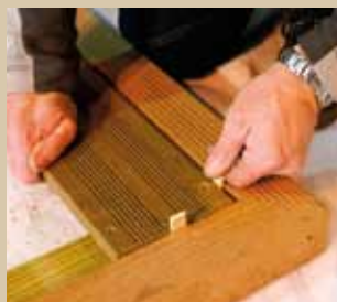
Pose sur lambourde et profil de finition. Lame pré-perçée.
