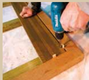
Vissage des lames par le dessus.
