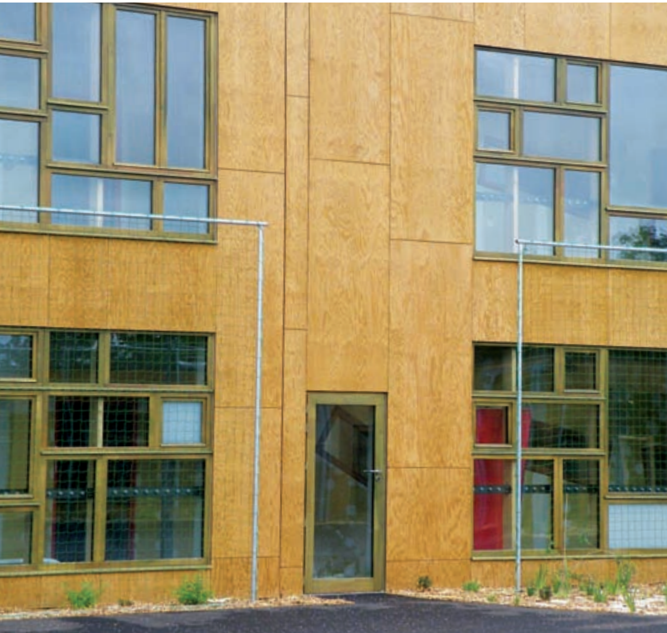
Ecole Beaulieu de Chartres (28) conçue par l'architecte Edouard François (75) (ROLPIN)
