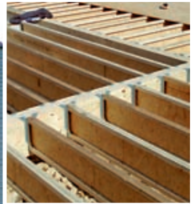
Planchers poutres en I
