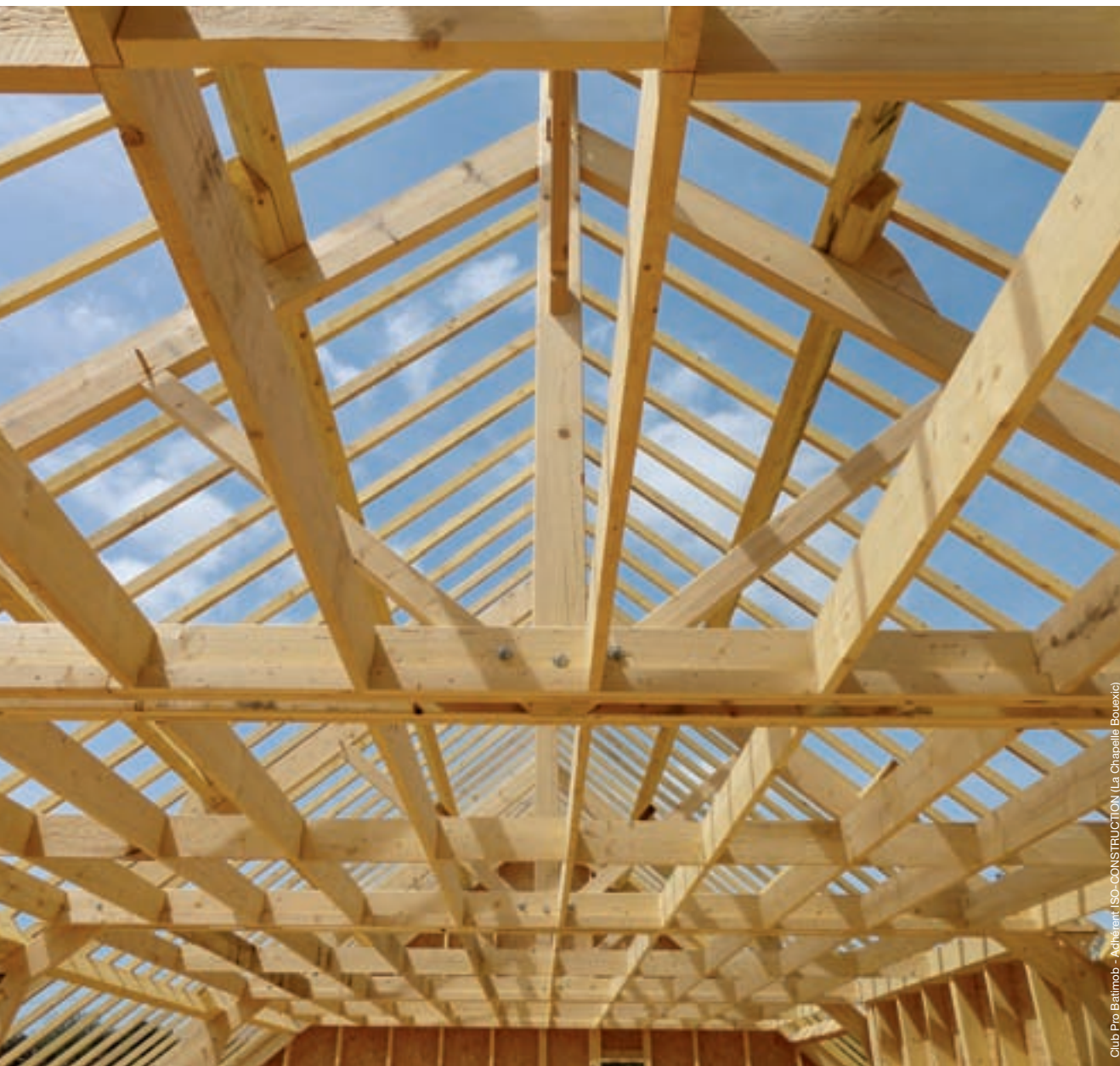
Chantier de charpente traditionnelle
