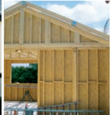
Murs à ossature bois
