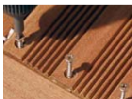
Vissage, fixation des lames
