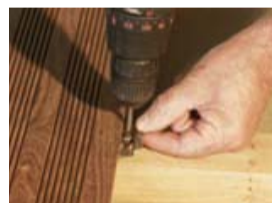
Mise en place du clip inox avec vissage partiel
