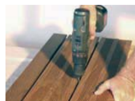
Serrage de la vis avec embout de finition
