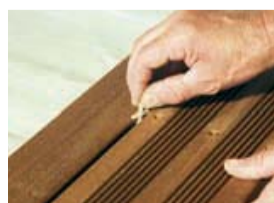
Cale pour joint de dilatation entre les lames
