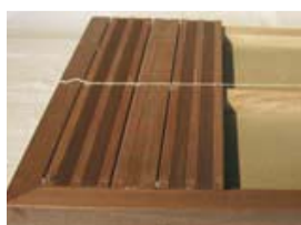
Ficelle pour un meilleur alignement des vis
