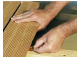
Mise en place du clip polypropylène
