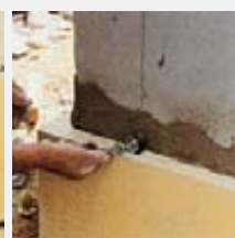
5. Fixation par vissage de l'agrafe
