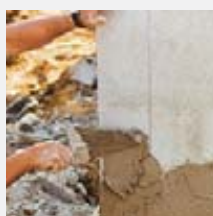
2. Encollage du mur
