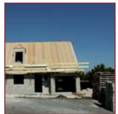
Jour 2 - 12h : Toiture prête à recevoir la couverture
