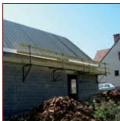
Jour 1 : pose des panneaux
