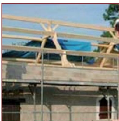
Jour 0 : pose de la charpente
