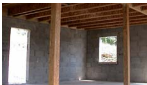
Plancher d'étage sur mur maçonné
