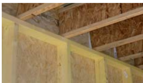
Plancher d'étage sur ossature bois
