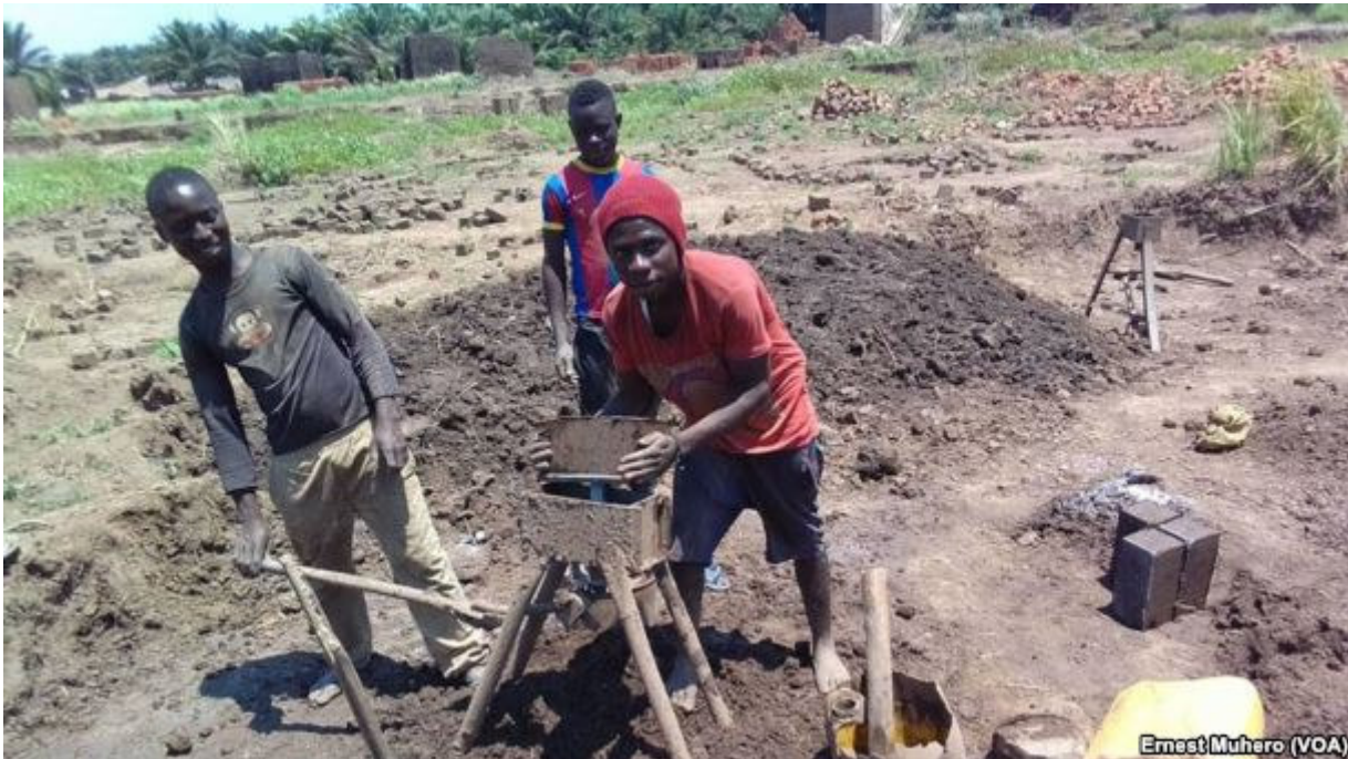
Des jeunes en train de fabriquer des briques écologiques, à Bukavu, Sud-Kivu, 2 janvier 2017. (VOA/ Ernest Muhero)
