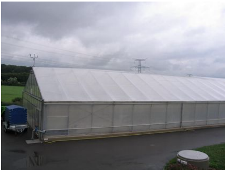
Photo 2 : Serre fermée à Folschwiller (57)
