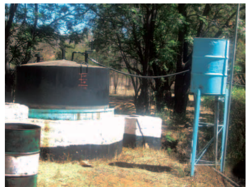
Le réservoir de collecte des gaz s'appuie sur un digesteur construit en béton. Les tuyaux / tubes au sommet du réservoir de gaz approvisionnent la maison avec du gaz méthane, au Botswana. (Reuben Sebege)
