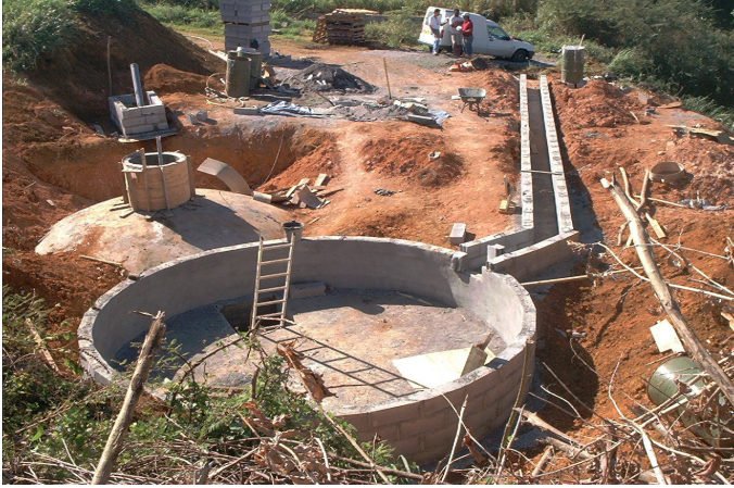
Digesteur avant le remblai
