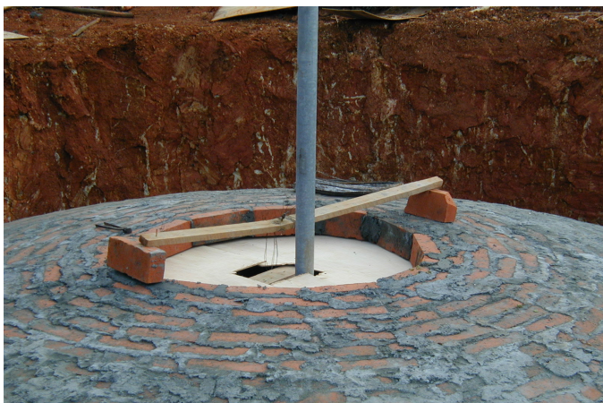
Système externe de maintien des dernières briques
