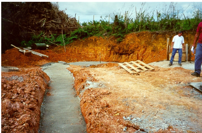
Dalle du canal d'évacuation
