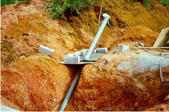
Dalle du bassin d'alimentation
