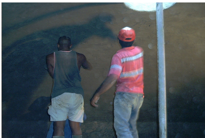
Application de l'enduit à l'intérieur de la coupole
