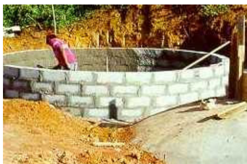
Passage de l'enduit à l'intérieur du bassin de compensation
