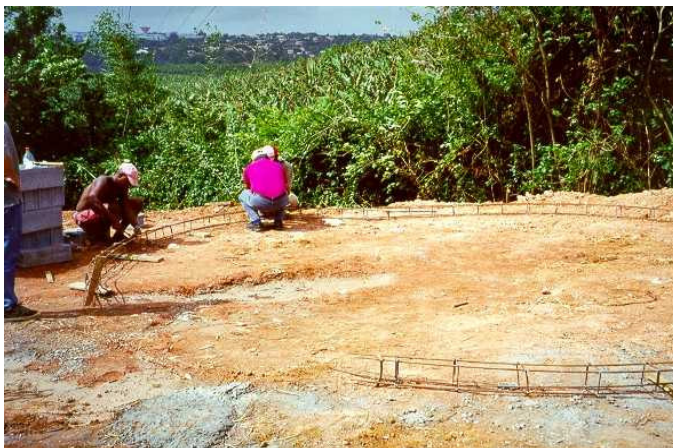
Montage des fers à béton du premier chaînage
