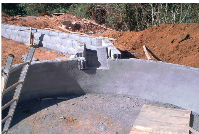
Jonction bassin de compensation / canal d'évacuation
