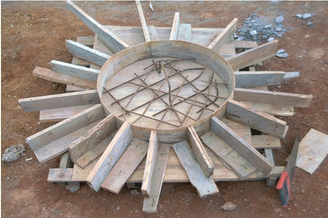
Coffrage du couvercle du premier étage de la cheminée
