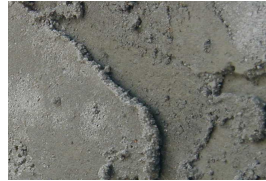
Rugosité de l'enduit
