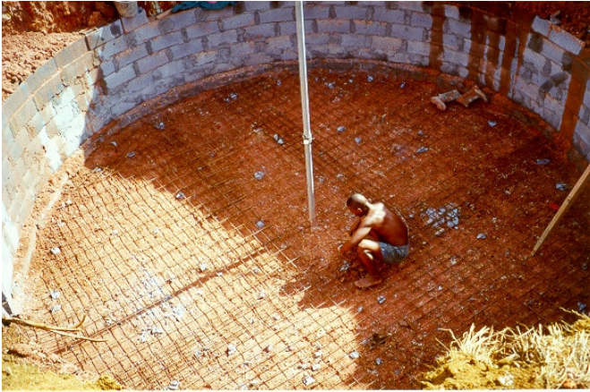
Pose des fers à béton
