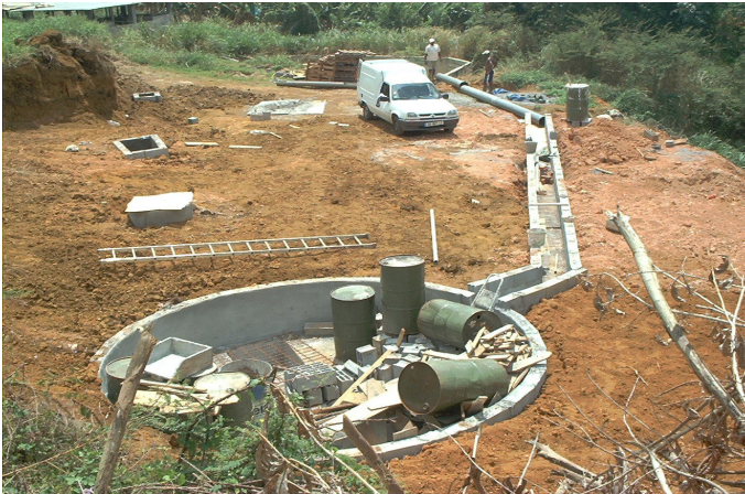
Digesteur après le remblai
