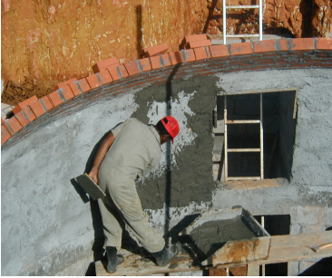
Passage de l'enduit
