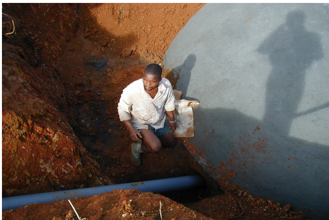
Pose du tuyau d'alimentation
