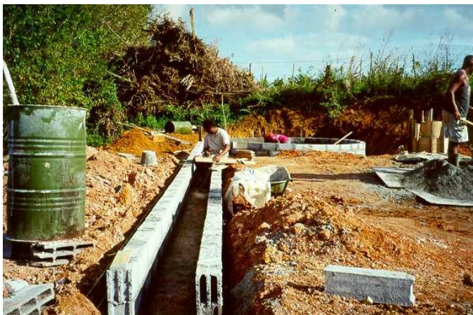
Le canal d'évacuation
