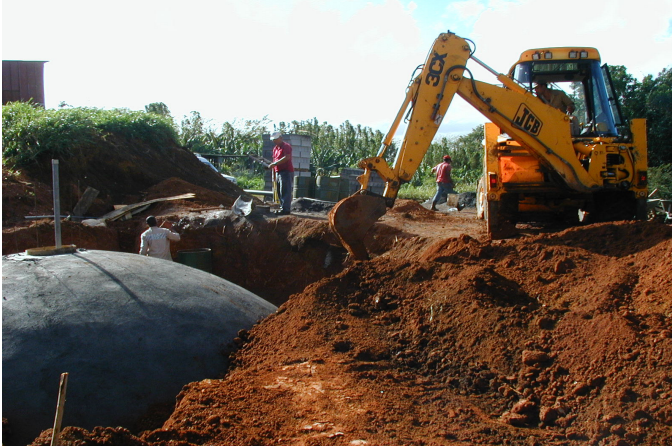
Excavation du bassin de compensation et du canal d'évacuation
