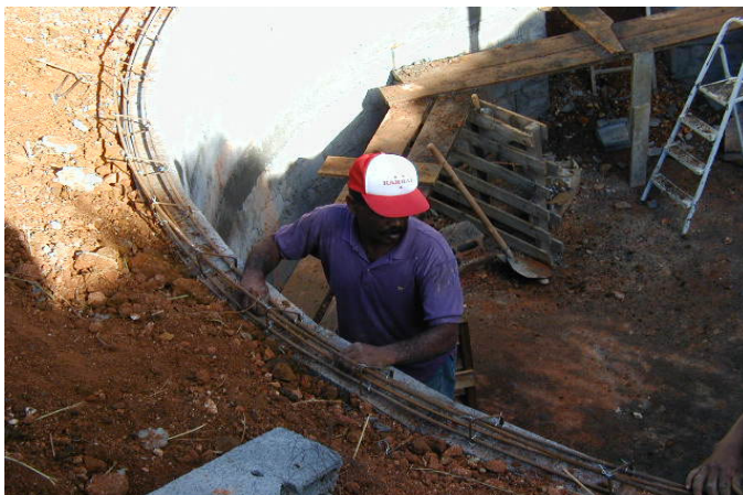
Pose des fers à béton du deuxième chaînage
