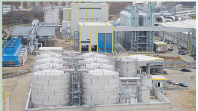
Südzucker Bioethanol, basé à Mannheim, Allemagne, produit de l'E85 à partir de leur récente installation (Fév. 2006) à Zeitz qui coûte 200 millions d'Euros. Elle produit 260 millions de litres de bioethanol par an à partir de ressource à haute valeur protéinique, principalement le blé.
