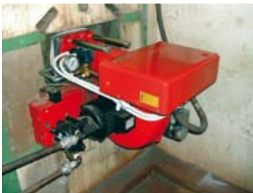
Photo 11 : Brûleur spécial huiles végétales Riello/Cirad ; 300 à 1100 kW Huile de palme brute, Cameroun, 2007. (Photo Cirad)
