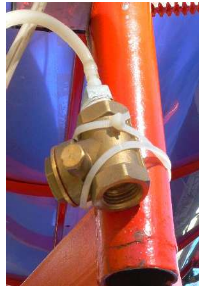
La vanne qui sert à aérer le système quand la pression baisse.
