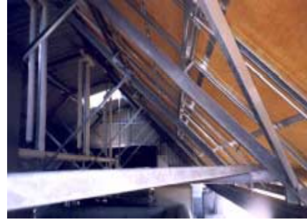
Isolation d'un champs de capteurs avec de la laine de roche semi-rigide.
