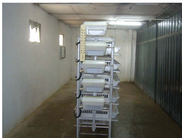
Une salle pour la reproduction aménagée d'une batterie à 5 étages
