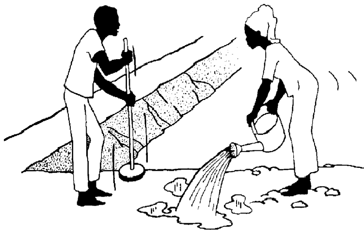
Figure 13 : Compacter une digue (Viveen et al., 1985)
