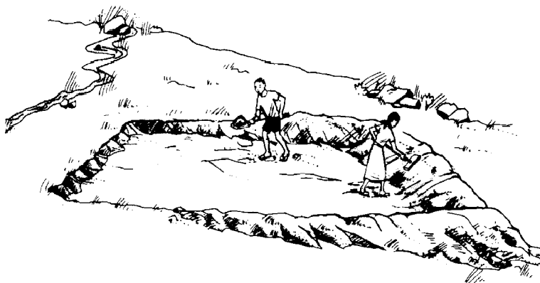
Figure 8 : Etang partiellement creusé et endigué (Murnyak, 1990)
