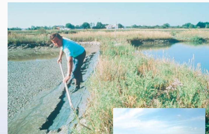
▲ Drouage (réfection des bords et des abotdeaux) d'une claire ostréicole, marais de la Seudre.
