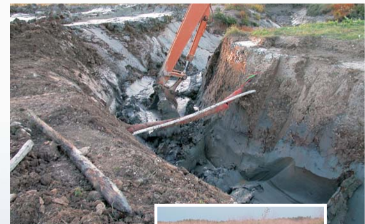
Remise en état de fossés à poissons, bassin de la Seudre
