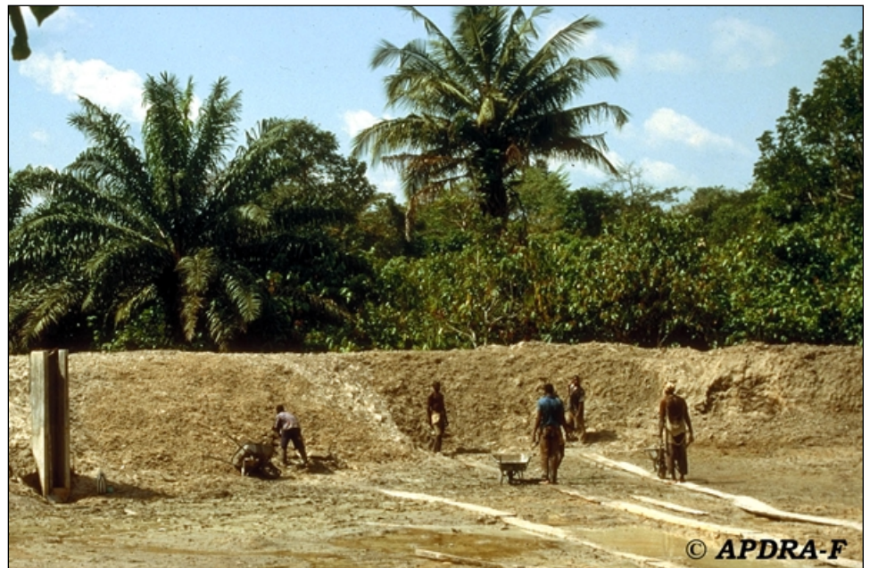
Photo 2 : groupe de travail construisant un étang de barrage en zone rurale (Côte d'Ivoire).
