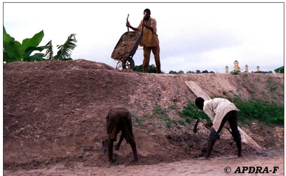
Photo 1 : tâcherons construisant un étang en zone périurbaine (Côte d'Ivoire).
