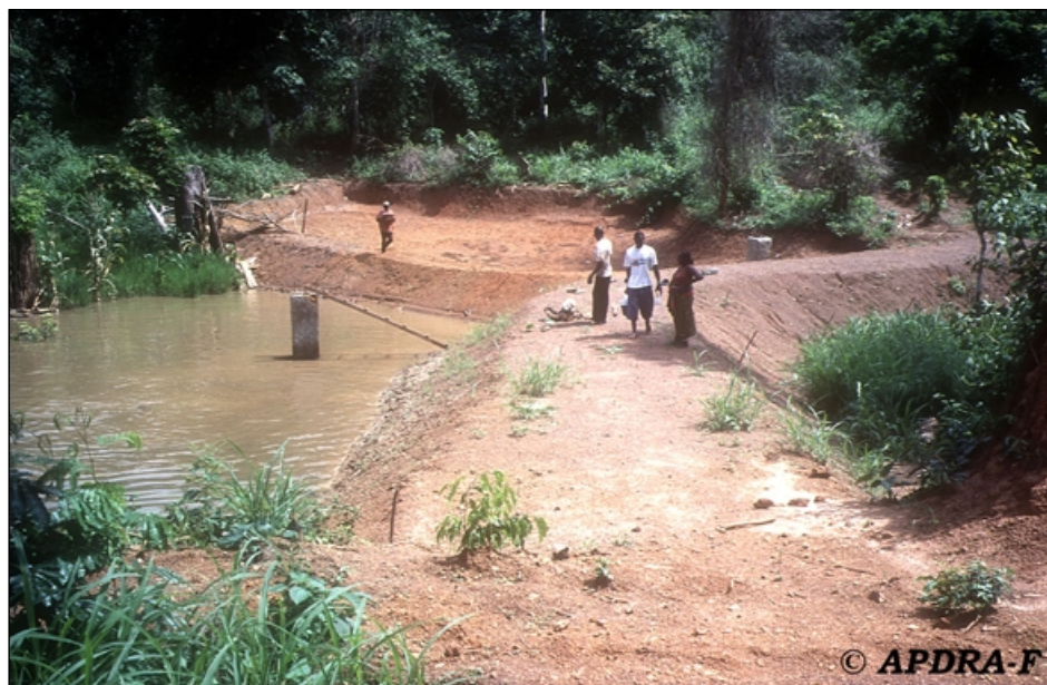
Photo 15 : exemple d'un étang de barrage (à gauche) muni d'un étang intérieur de service (Côte d'Ivoire).
