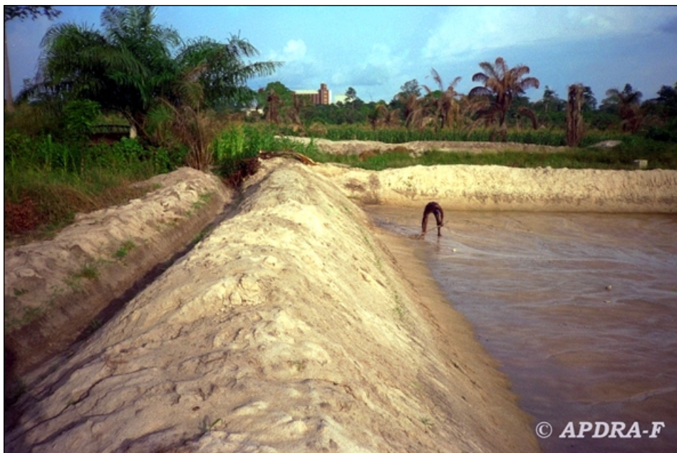
Photo 7 : aperçu du travail de terrassement en périurbain pour un étang de 4 ares (Côte d'Ivoire).
