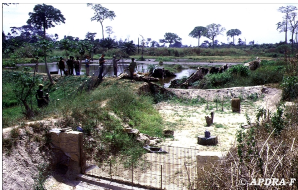
Photo 17 : trop-plein grillagé d'un grand étang de barrage (Côte d'Ivoire).
