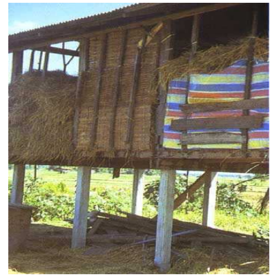
Figure 11 : Aménagement d'un grenier sur pilotis pour le traitement des pailles à l'urée Source : Chenost et Kayouli (1997)
