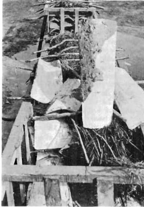
FIG. 7. — Effet du gel sur l'enduit calcaire des collecteurs (photo LE DANTEC).
