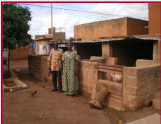
PHOTO 10: Porcherie améliorée contiguë au bâtiment d'habitation (Koudougou, Province du Boulkiemdé)
