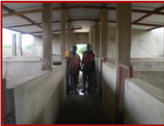
PHOTO 17: Personnel et bâtiment de la porcherie SANOU (membre de la MEP, Bobo-Dioulasso)
