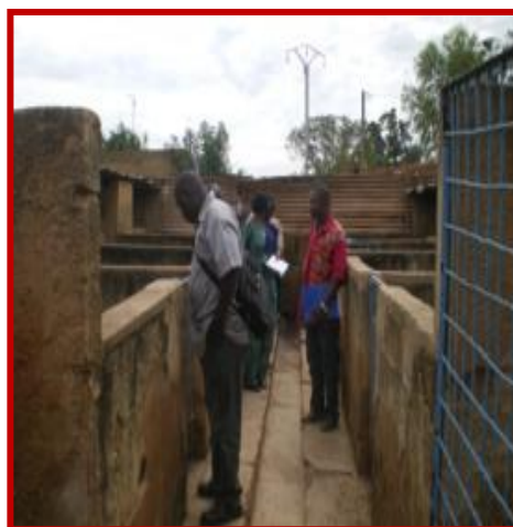
PHOTO 5: Petite porcherie urbaine avec 2 rangées de loges en matériaux durables (Ouagadougou, Province du Kadiogo)
