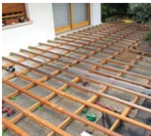
Structure sur cales sur sol dur
