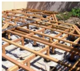
Structure sur plots sur sol stabilisé
