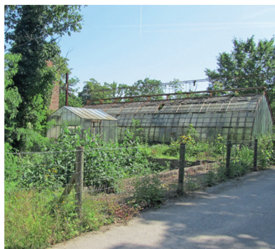
Rénovation des serres à l'étude dans l'ancien jardin des cultures
