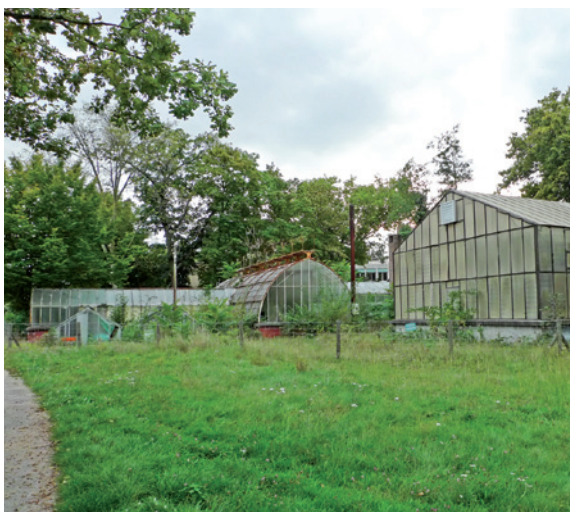
La réhabilitation à l'étude des serres historiques : un élément du projet du jardin pédagogique. La serre récente : à supprimer ou à déplacer
