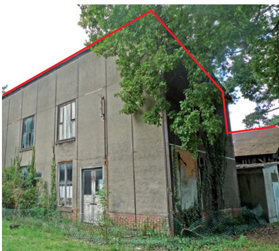
Démolition programmée des bâtiments 21 et 20, désaffectés du campus
