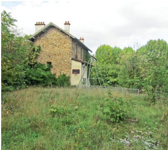
Un espace central banalisé à décloisonner et à réinvestir sur la base de la trame historique. La maison du jardinier de 1910 est peut-être à démolir
