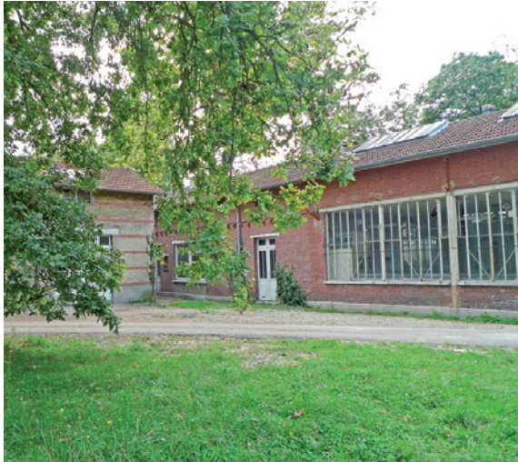
Un ensemble de bâtiments fonctionnels à rendre lisible en pourtour de l'ancien jardin cultivé
