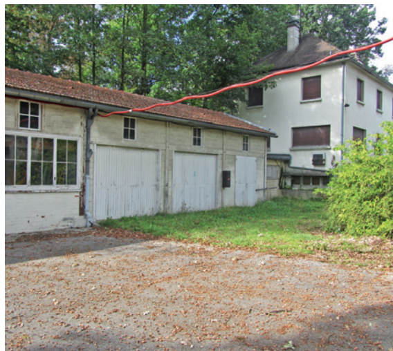
Les bâtiments désaffectés situés en rive du bois : une limite peu qualitative
