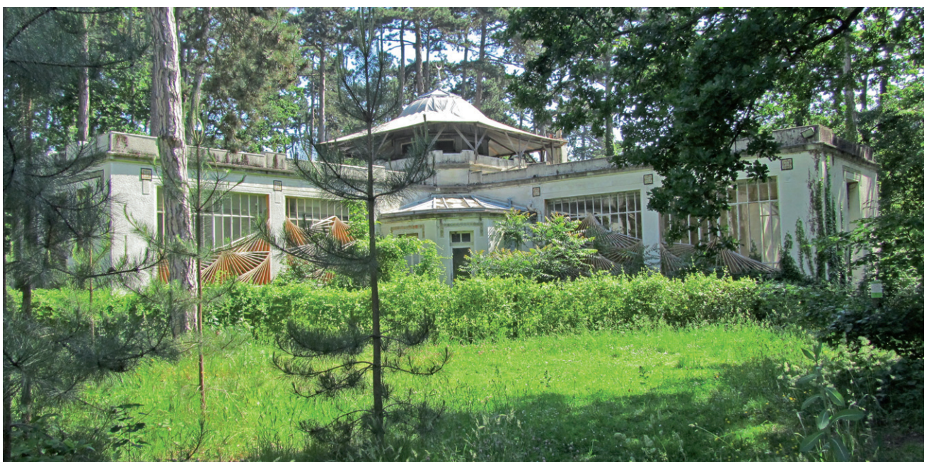
Le pavillon de Tunisie, une rénovation programmée en espace de restauration, buvette et d'accueil du jardin
