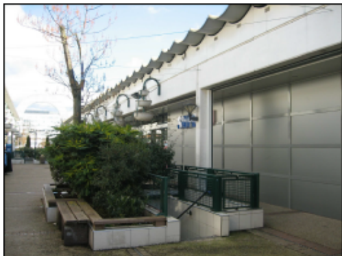
cage d'escalier existante
